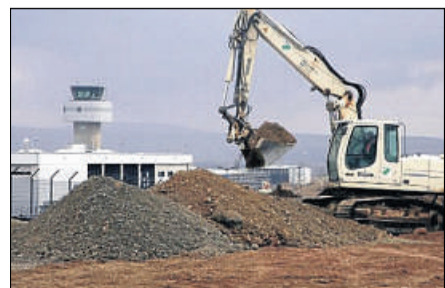
Die Grünen im Landtag vermuten, dass beim Bau in Calden gemauschelt wurde. Foto: Thiele
